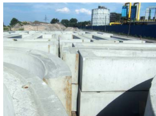
Fot. 2. Zbrojenie I segmentu płyty fundamentowej. W tle portal iniekcyjny
